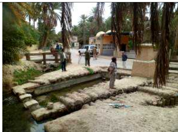
Construction à l'intérieur de l'oasis de Tozeur
