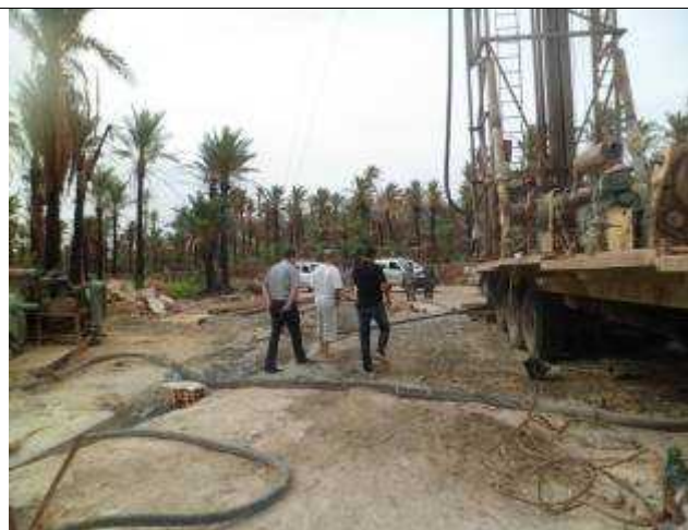
Creusage d'un nouveau forage dans l'oasis de Tozeur (2013)
