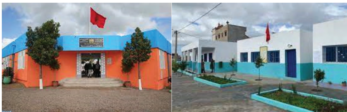
14 : embellissement extérieur et intérieur de l'école avec création d'espace de jardinage scolaire dans le cadre de la vie scolaire
